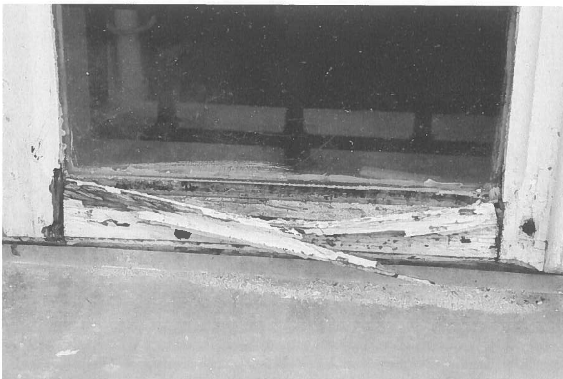
Fot. 2. Zły stan zachowania drewna w dolnych partiach okienka w podpiwniczeniu (strona północna pałacyku). Widoczne osłabione drewno spowodowane zamakaniem wody deszczowej, złuszczenia warstwy farby.
