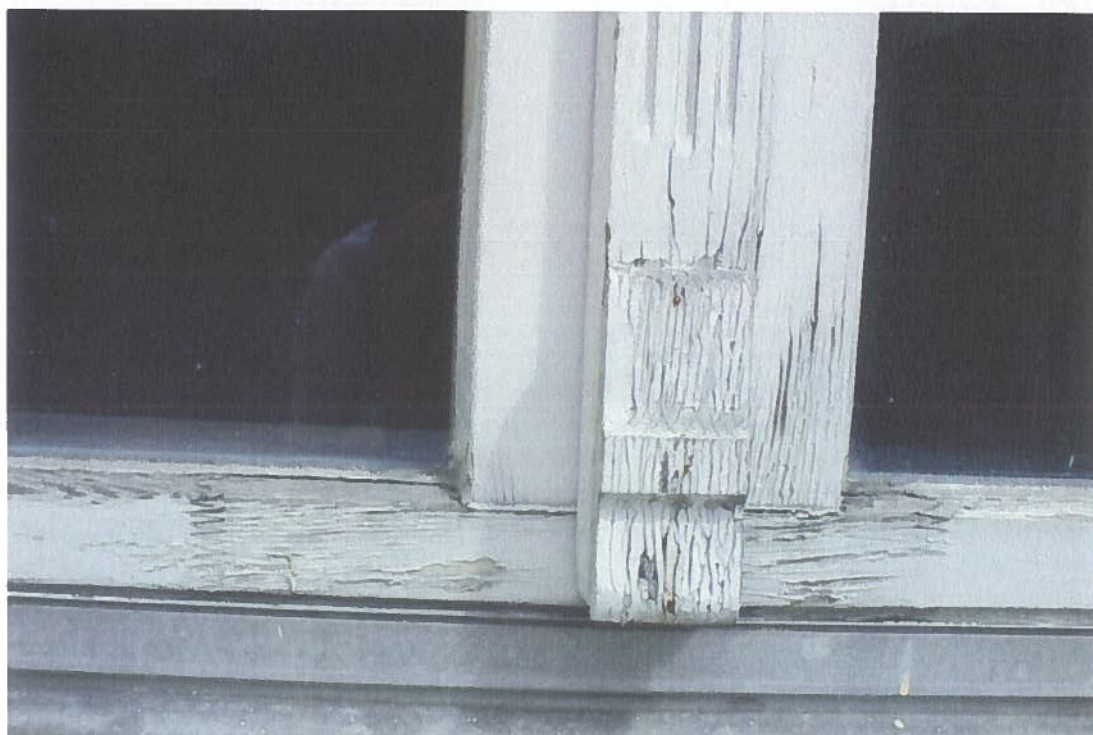
Fot.3. Zły stan zachowania drewna w oknach. Widoczne osłabione drewno spowodowane zamakaniem wody deszczowej, złuszczenia warstwy farby.
