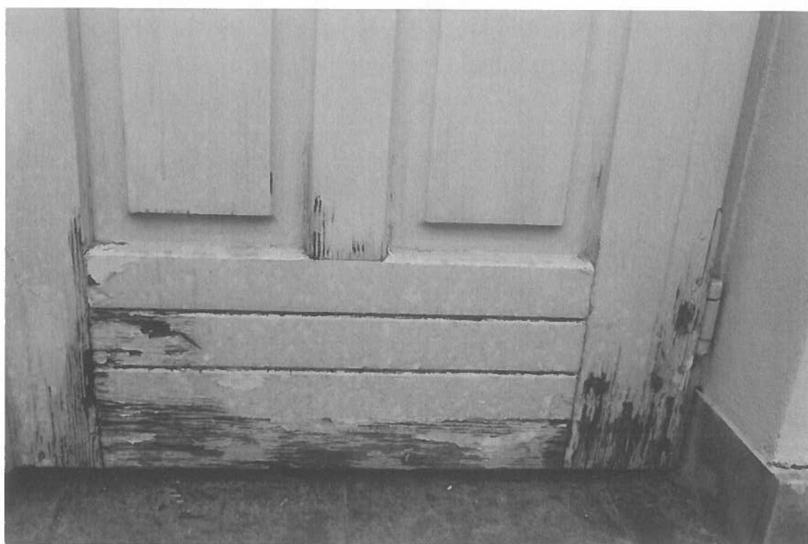
Fot. 1. Zły stan zachowania drewna w dolnych partiach drzwi wejściowych (strona zachodnia pałacyku). Widoczne osłabione drewno spowodowane zamakaniem wody deszczowej, złuszczenia warstwy farby.
