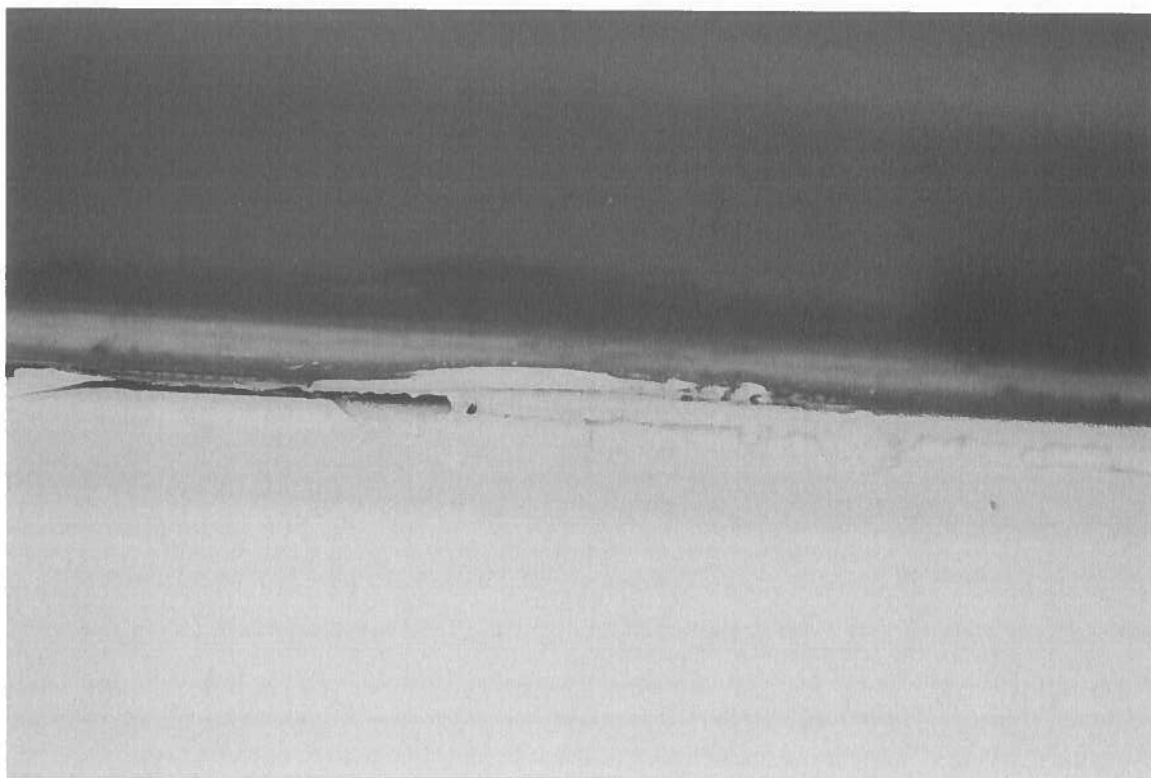
Fot.5. zły stan zachowania uszczelnienia szyb. Widoczny kruszący się kit, który stracił elastyczność i przestał pełnić swoją funkcję
